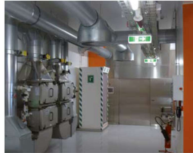
Abb. 4 Bau für S3-Experimente
